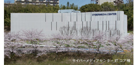
サイバーメディアセンター IT コア棟
